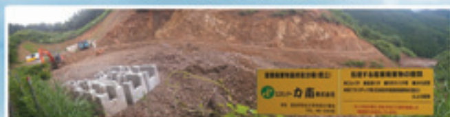
安定型最終処分場
